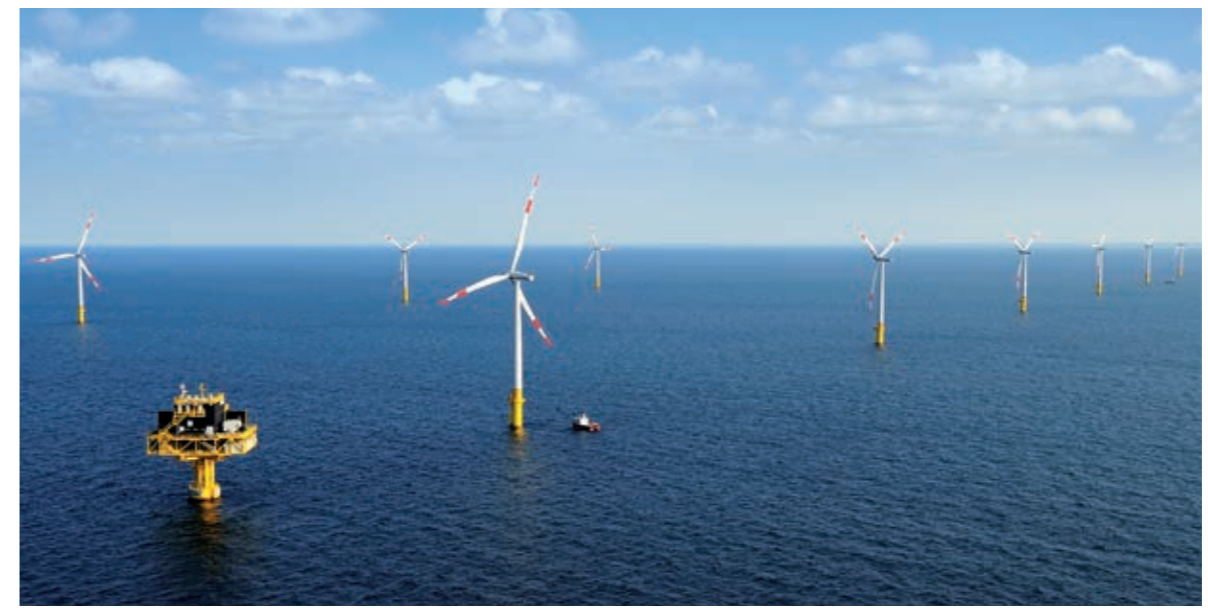
Der EnBW Windpark Baltic 1 – der erste kommerzielle Windpark Deutschlands in der Ostsee.
