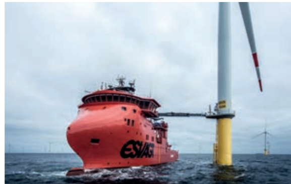
Über die „Apelmann-Brücke“ gelangen die Techniker sicher zur Windkraftanlage.
