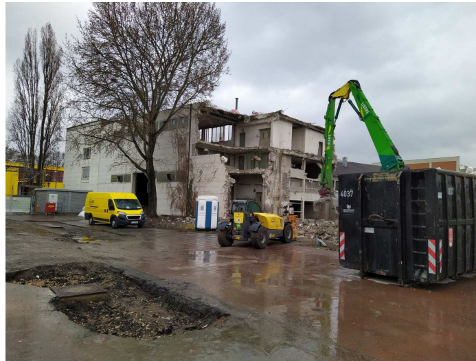
Abb: aktuelle Abbrucharbeiten
