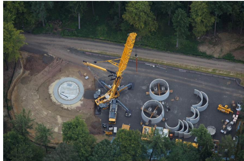
Windpark Winterbach- Montage Turm
