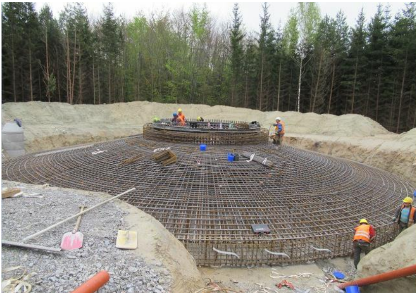
Windpark Fichtenau – Fundament im Bau
