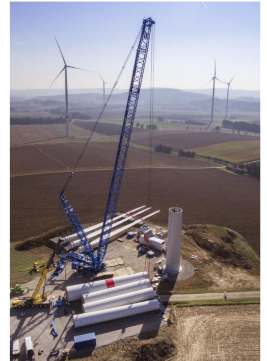
Windpark Rot am See – Kran
