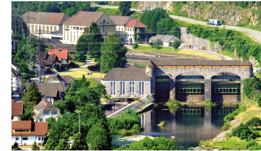
Die Wehranlage und das Niederdruckwerk in Forbach. Im Hintergrund ist das Murg- und Schwarzenbachwerk zu sehen
