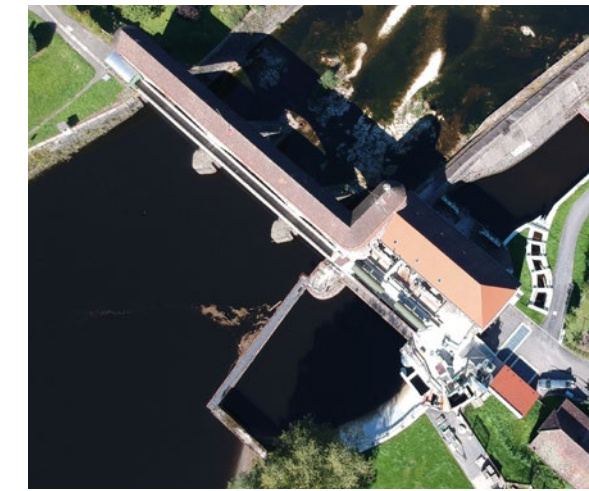
Übersicht der Fischliftanlage am Wehr Kirschbaumwasen
